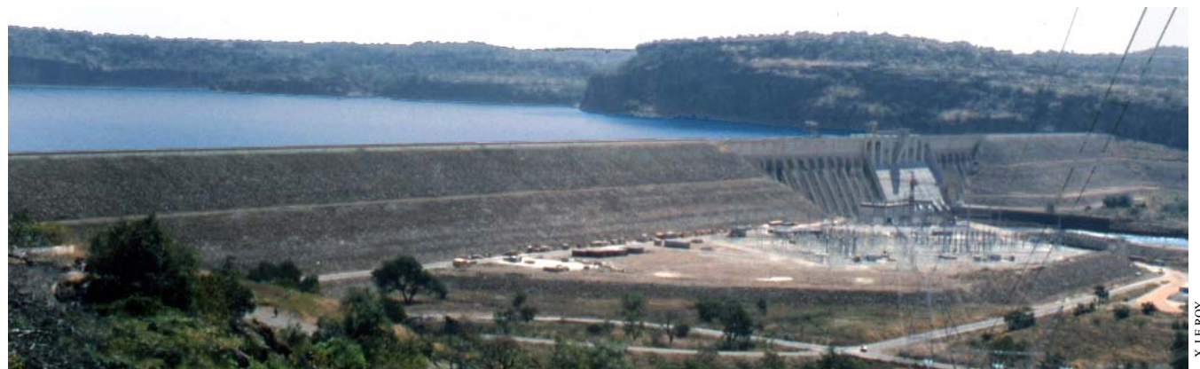
Figure 10. Barrage de Manantali
