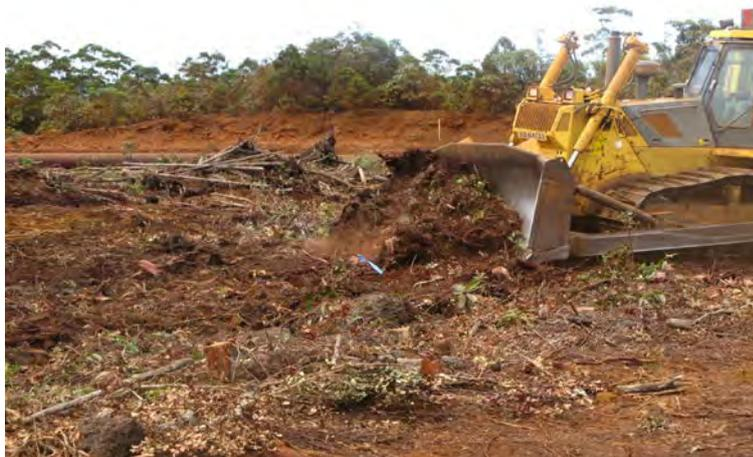
**Figure 10 : Récupération du topsoil après décapage**
