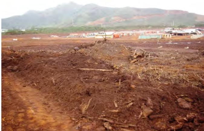
**Figure 14 : Topsoil étalé (50 cm d'épaisseur environ)**
