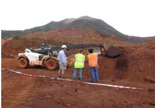
**Figure 15 : Mise en place du topsoil stocké en andain sur la mine de vulcain à Tontouta (août 2011)**
