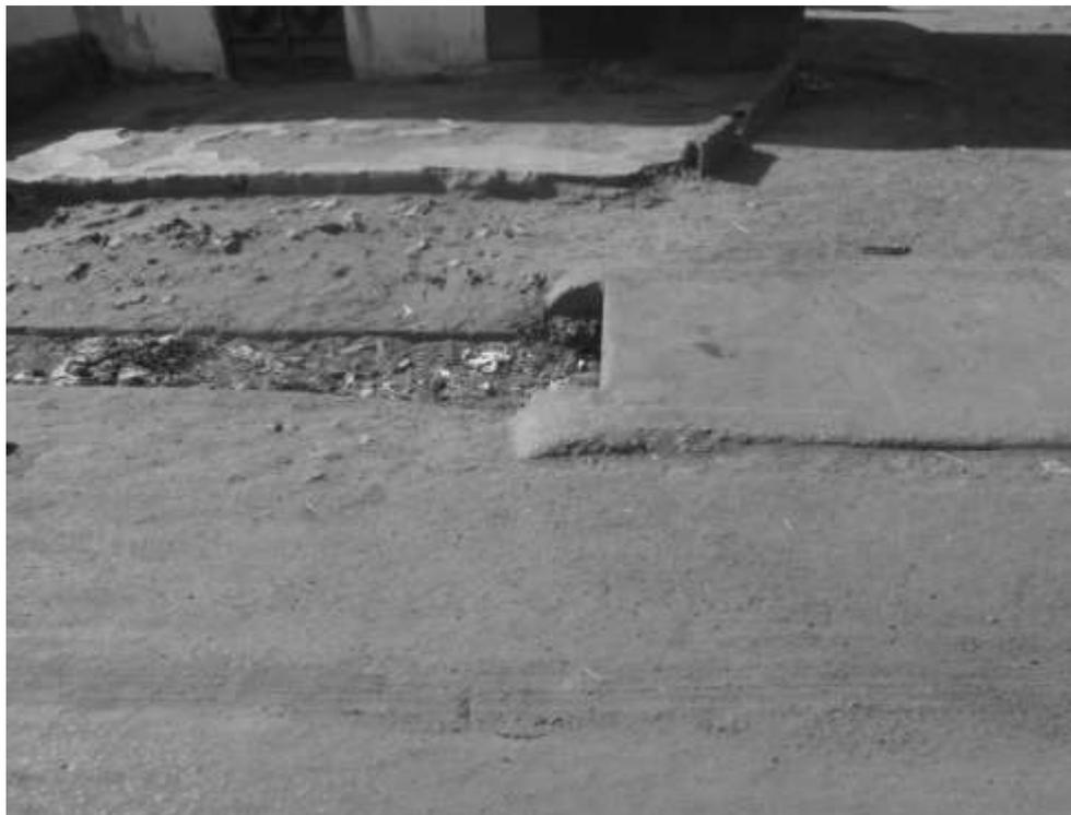
**Figure 14. Photo prise fin novembre 2013 montrant un caniveau bouché (Banconi, Bamako)**
