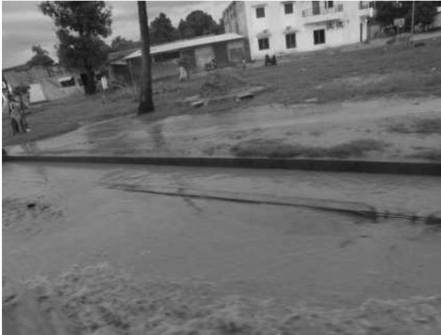
**Figure 15. Caniveau fonctionnel (mais en fait en grande partie comblé de sédiments et débris), Ziguinchor, quartier Kandé, août 2014**
