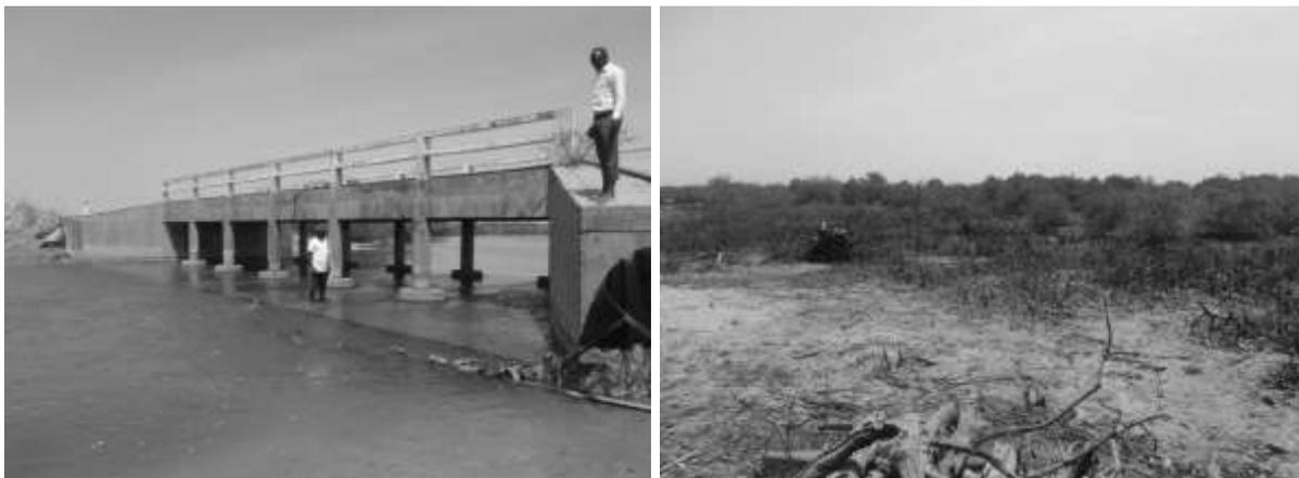
**Figure 13 : à gauche un des trois ponts construits sur la piste entre Etama et Bandial (Basse Casamance) ; le bolon a cinq ou six mètres de profondeur ; or la semelle du pont émerge la plupart du temps, laissant passer de très faibles volumes de marée ; à droite : la mangrove morte en « amont » des ponts**
