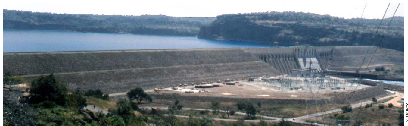
Figure 10. Barrage de Manantali
