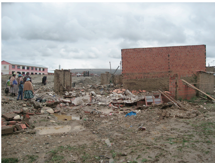
Fotografía N° 2: la zona de Huayna Potosí (distrito 5) dañada por la inundación del río Seco en enero 2008 (A. Gizon, COOPI, enero de 2008).
